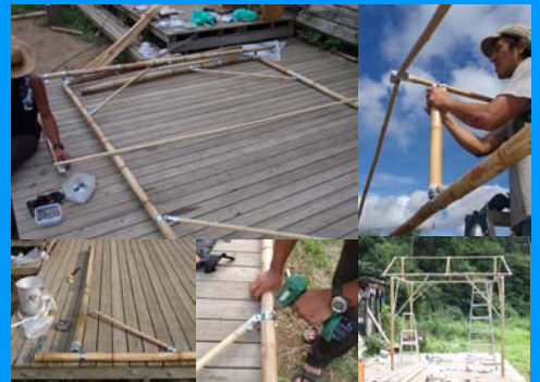
竹テント部材の加工・取付
